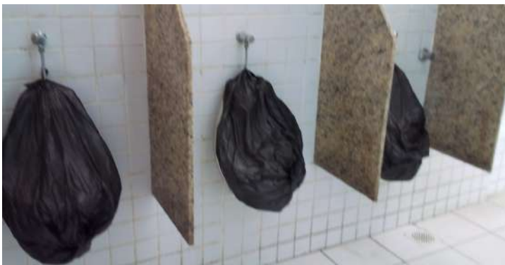
Imagem: Banheiro do CDD Centro João Pessoa
